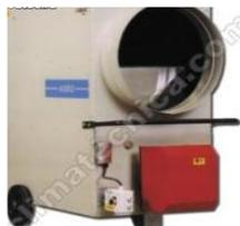
Con los quemadores pequeños el control de CO<sub>2</sub> es limitado y pueden operar solo a pequeña capacidad (encendido/apagado); además, los gases de la chimenea se expanden libremente, y generan una distribución poco homogénea dentro del invernadero.
